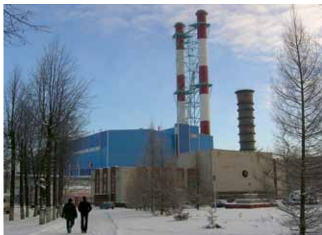
▲ Компания ОАО «Ивэлектроналадка» многие годы успешно выполняет комплекс высококвалифицированных работ в энергетике
